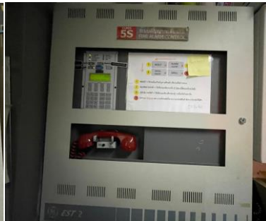
แผงควบคุม (Fire Alarm Control Panel : FCP)
