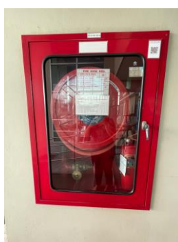
ตู้เก็บสายฉีดน้ำดับเพลิง พร้อมอุปกรณ์
