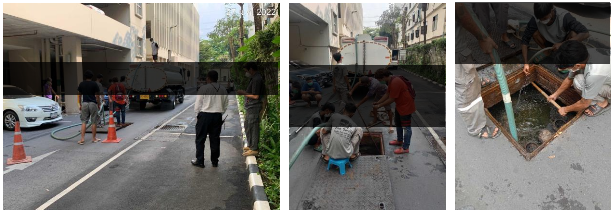
รูปที่ 2-26 สูบไขมันและสูบตะกอนส่วนเกินเมื่อวันที่ 27 มกราคม 2565
